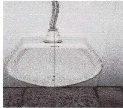
Foto 8: Finalización de sustitución de mejitorios.
