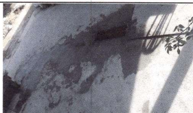
Foto 4: Finalización de reparación de red de drenaje y red de agua potable.
