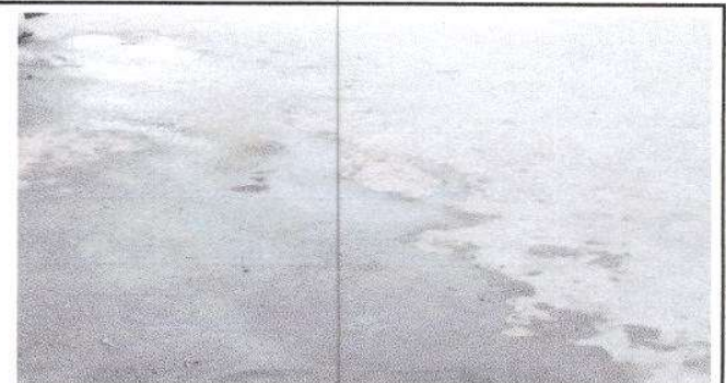
Foto 12: Finalización de reparación de piso de torta de concreto.
