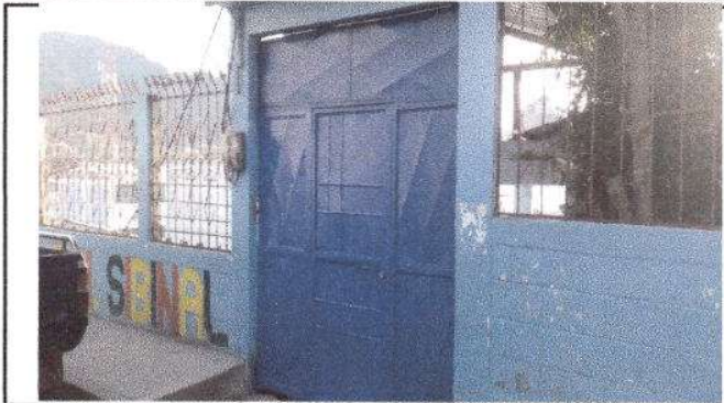
Foto 7: Finalización de sustitución de puerta de metal.
