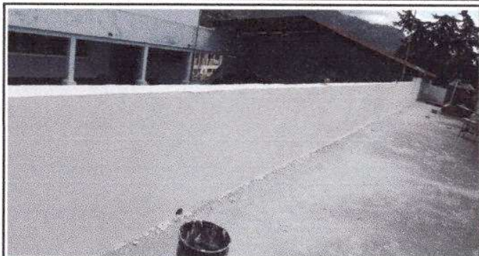
Foto1: Finalización de reparación de repello y sernido de paredes.
