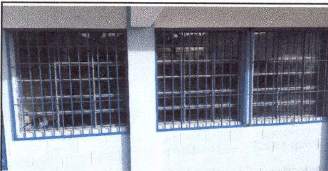
Foto 11: Finalización de sustitución de balcones de metal.
