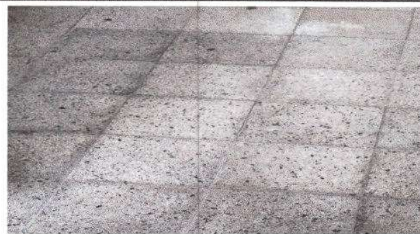
Foto 2: Finalización de mantenimiento de piso de granito.
