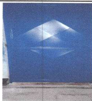
Foto 6: Finalización de sustitución de puertas en servicio sanitario.
